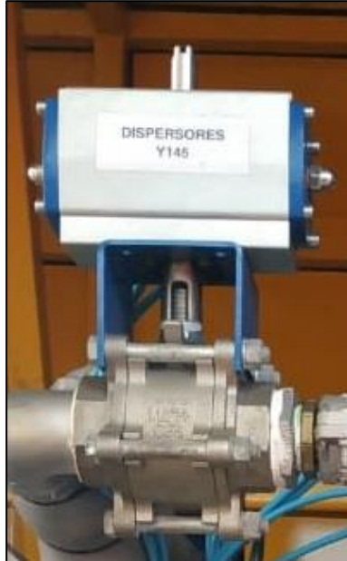
Figura 102: Atuador Pneumático
