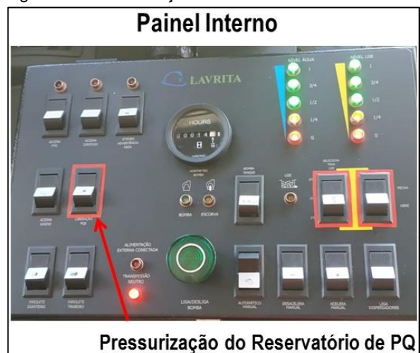
Figura 91: Pressurização do Reservatório de PQ
