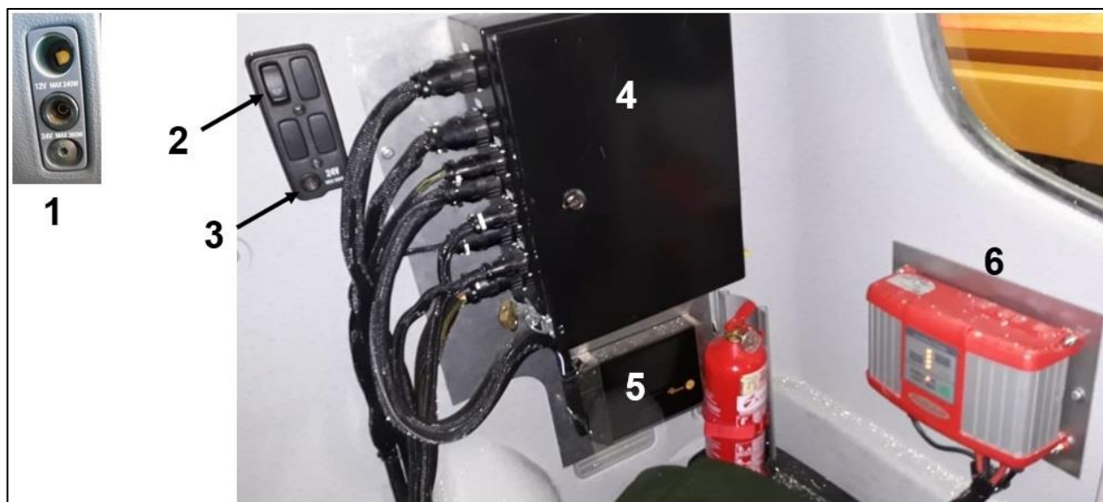
Figura 45: Tomadas Elétricas, Centrais Eletrônicas e Recarregador de Bateria
