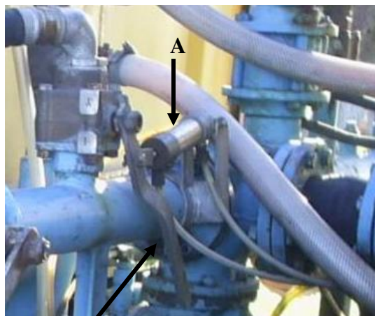
A- Válvula Pneumática B- Alavanca (haste) para acionamento manual.
